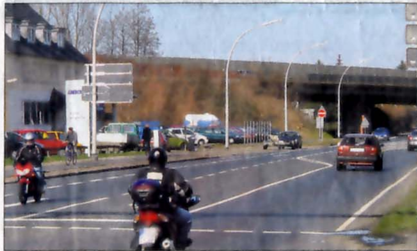
Blick auf das Autobahnkreuz Südwest aus Richtung Rüningen. Foto: Jonscher
