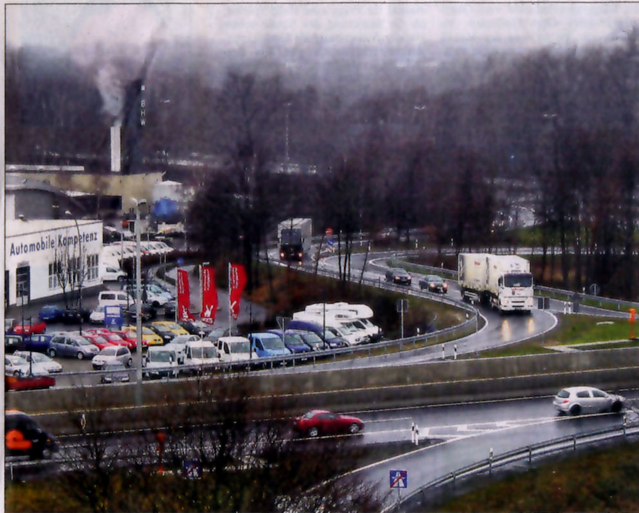
Viel zu schmale Rampen: das Autobahnkreuz Süd. Nichts wird hier so bleiben, wie es ist.
